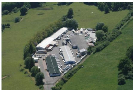
Luftbild Produktion (Zentrale) Am Lautenstein 5
