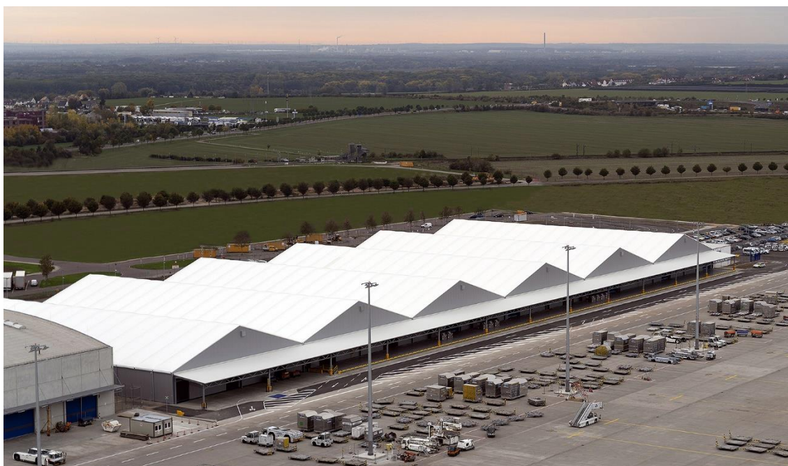
Modulares Fracht- und Sortierzentrum am Flughafen Leipzig/Halle
